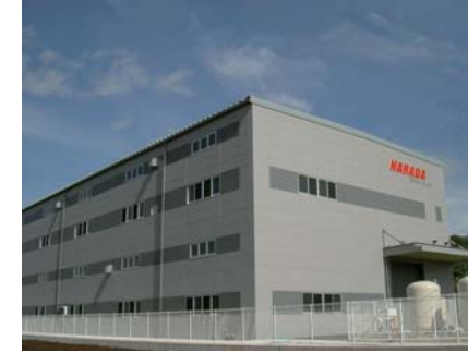
平成19年度に建設した神野々工場
