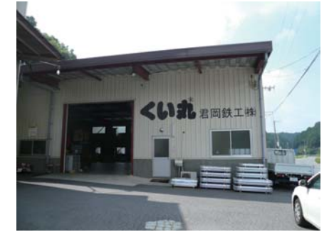
経営革新認定を受けて建設した倉庫
