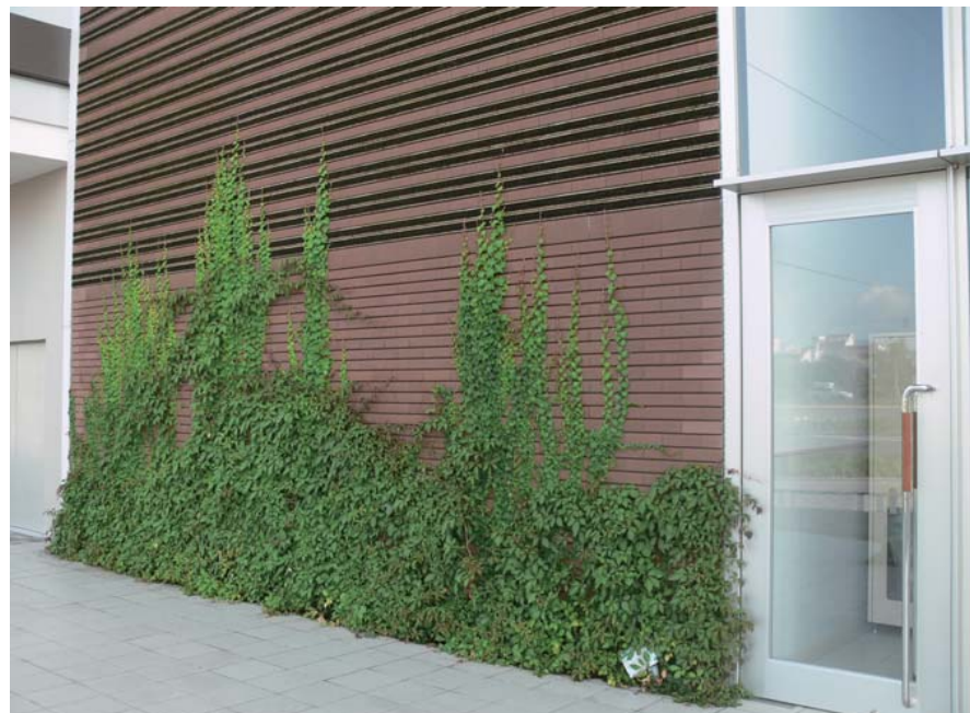
地域資源活用型研究開発事業による『打水冷却タイル(ツタタイル)』。イオンモール草津に施工された
