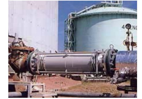
油タンク元用伸縮管継手
