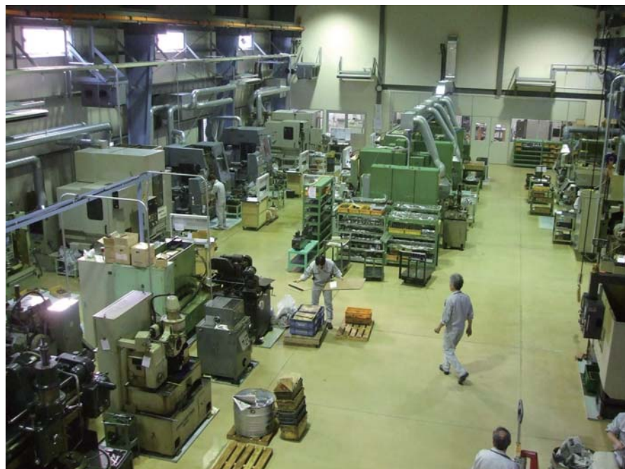
建て替えられた工場内に並ぶ機械設備
