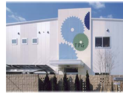
“町工場”には見えない新本社工場の外観
