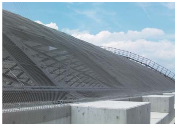
高速道路に設置された飛球防護網。
