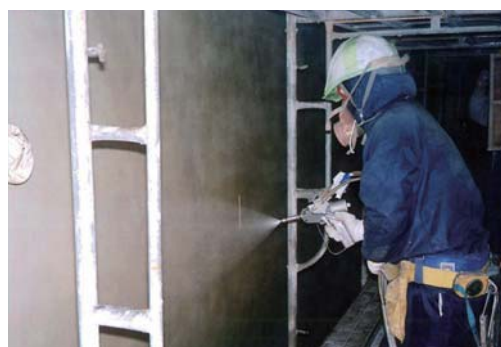
ネブライジング工法による吹き付け現場
