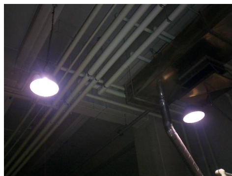
水銀灯の高効率化(低電力量で同等以上明るい電球に交換)
