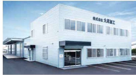
大昇加工 八尾工場
