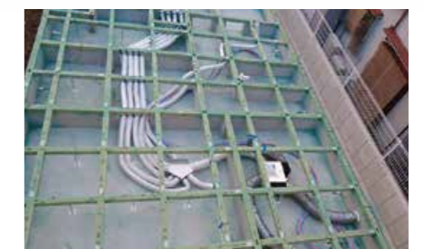
澄家Eco換気システムの施工事例
