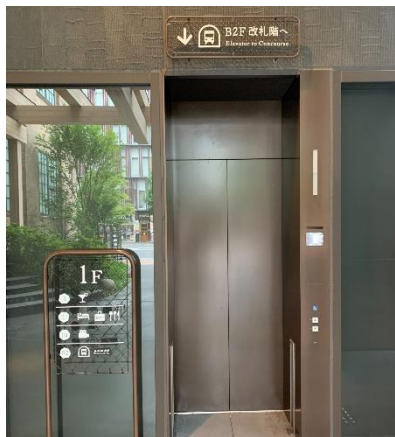
硫化いぶし色仕上げの施工事例 (京都府 新風館のエレベーター)
