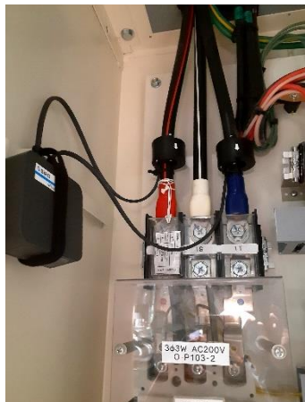
IoT電力センサの設置例
