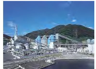
石炭火力発電所
