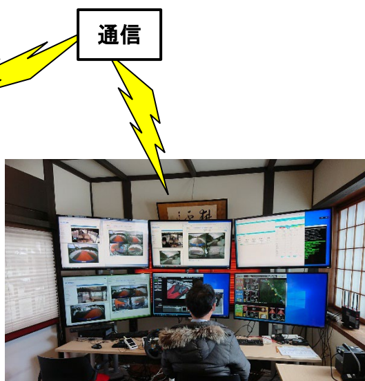
遠隔監視・操作室
