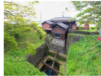
龍ヶ池揚水機場
