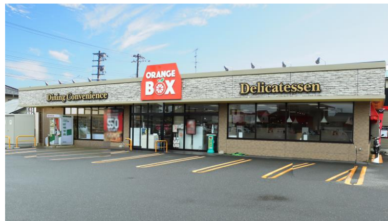
写真説明 : コンビニエンスストア（オレンジBOX）店舗外観
