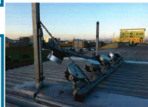
LED投光器が倒壊（被災時）
