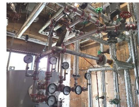
ステンレス鋼管用継手
