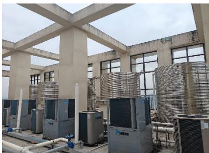
省エネ改造プロジェクト
