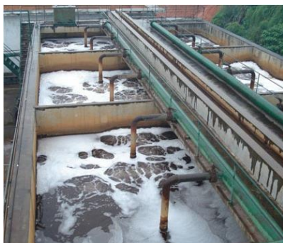
電気メッキ廃水処理工程
