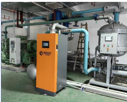
空気圧縮機排熱交換ユニット
