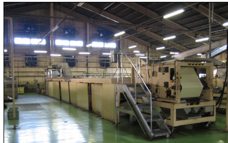
ガス式連続焼成機の全景
