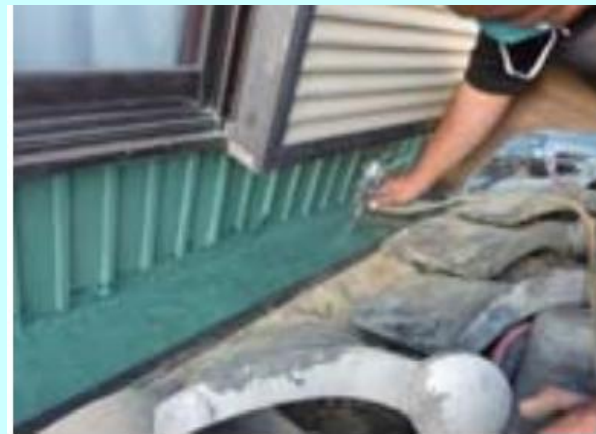
構造物の補修
