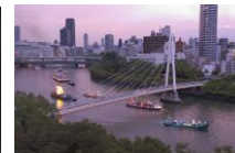
天神祭(大阪府) 写真提供:(公財)大阪観光局
