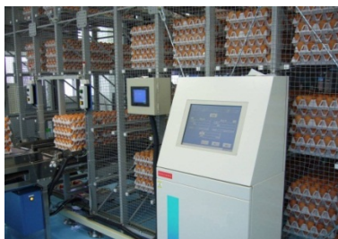
卵専用自動倉庫システム
