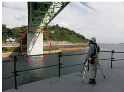
橋脚のひび割れ計測状況
