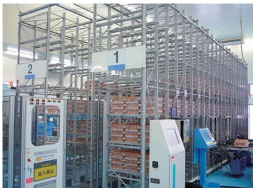
自動倉庫型選別包装システム (選別された卵を一時保管し、受注に応じて包装するシステム)
