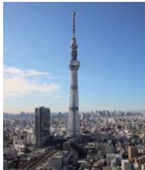
提供：大林組 事業主体：東武鉄道・東武タワースカイツリー
