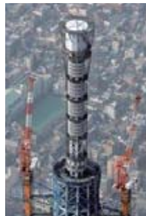
ゲイン塔（※地上デジタル放送用アンテナを取り付けた柱状設備）
