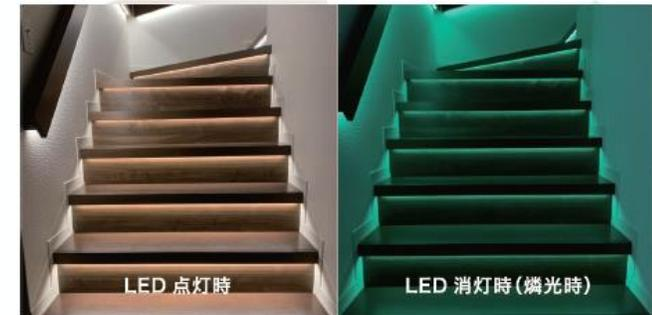
本製品最大の特徴は、「停電発生時に蓄光（燐光）により暗闇でも視界を確保できること」です。本体のシリコンチューブに蓄光機能を付加し、フレキシブルLED基板を内蔵しています。通常時は、LED照明として使用しながら本体シリコンチューブに光を蓄えることができ、災害などによって停電が発生した際には、蓄えた光を「燐光」として放つことが可能です。
