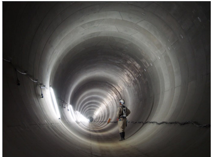
再生 PET 繊維を混入させたコンクリート製セグメントが採用された下水道トンネル
