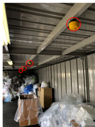
同社の廃プラスチック保管庫内の様子。天井部に設置したIoTセンサーが超音波で最も上にある廃棄物までの距離を1時間毎に測定し、その平均値から体積率を算出する。
