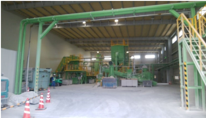
粉じんの拡散を徹底的に防止する集じんシステムを採用することで、粉塵による視界不良、危険作業から解放し、施設全体の作業環境の改善へとつなげている。
