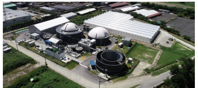
トーヨーバイオメタンガス発電所等の敷地全体。敷地面積9,000㎡の発電所と農業生産法人が運営するトマトのハウス栽培施設がある。
