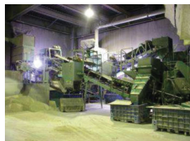
同社が所有する ALC 端材専用の破砕機。室内には専用の集じん機を装備している。
