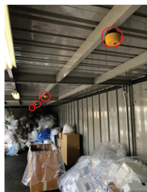
同社の廃プラスチック保管庫内の様子。天井部に設置したIoTセンサーが超音波で最も上にある廃棄物までの距離を1時間毎に測定し、その平均値から体積率を算出する。
