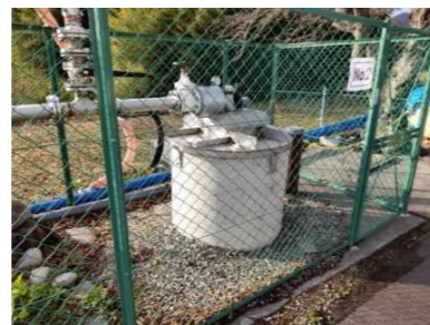
工場敷地内にある越知川水系の地下水を取水する井戸。井戸を掘りやすい岩盤であることも、この立地を選んだ理由の1つ
