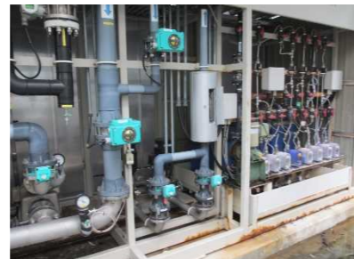
高度処理水設備における逆浸透(RO)膜ユニット
