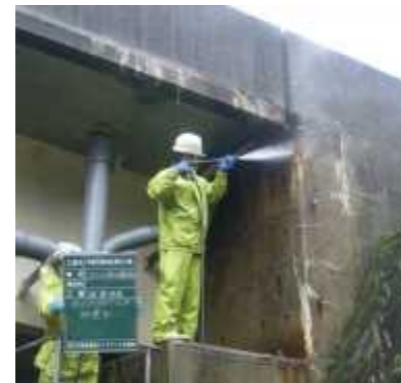
ウルトラファインバブル水による橋脚の高圧洗浄
