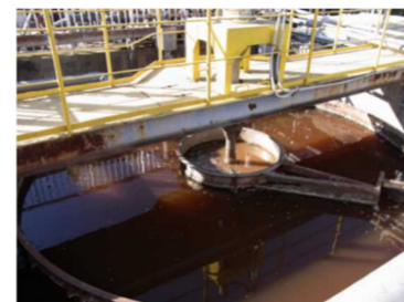
従前システムでの沈殿槽。必要な処理量に対する排水能力が十分ではなかったため、沈殿槽が濁り、汚泥沈降しない状態になることもあった。
