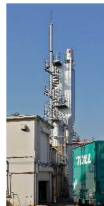
設置スペースが限られていたため、タワー型嫌気処理システム「ICリアクター」を採用。
