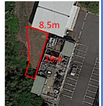
タワー型嫌気処理と発電機の設置場所。写真左側の緑地帯が加古川に面している。
