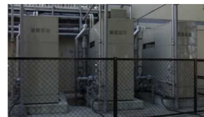
バイオガス発電機(25kW)を3台設置。発電量は平均1,000kWh/日
