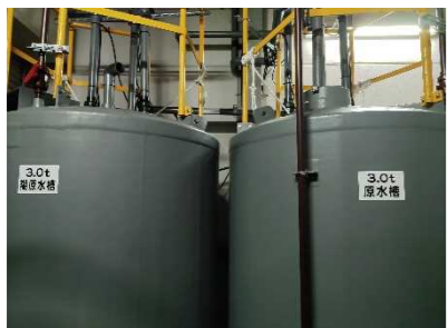
原水槽として、糊を含む排水と、含まない排水をそれぞれ別の槽に貯めている。
