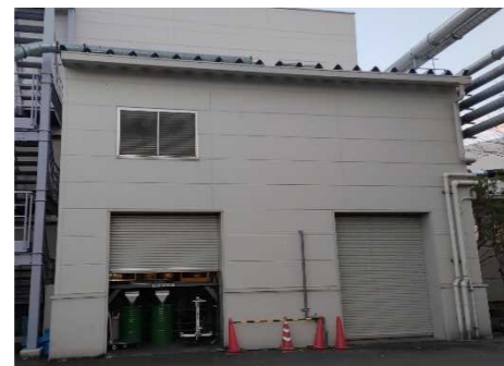
排水処理システムが入る建屋。間口10m、奥行5mの中に全てのシステムが入っている。
