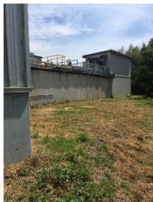
プラント設置場所
