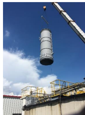
機器搬入工事
