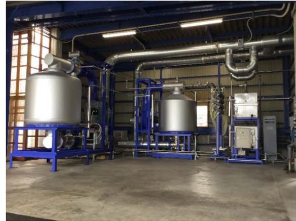
ろ過装置。各洗浄装置のダクトは全てここに繋がっている。活性炭によりトリクロロエチレンの成分を吸着後、排気している。
