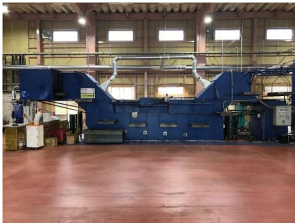
シャワー式洗浄装置のダクト設計では、出入口の開口面積を小さくすることで局所排気の制御風速 0.4m/s を確保し、工場内への排出を抑制。ダクト接続位置の選定にも配慮している。
