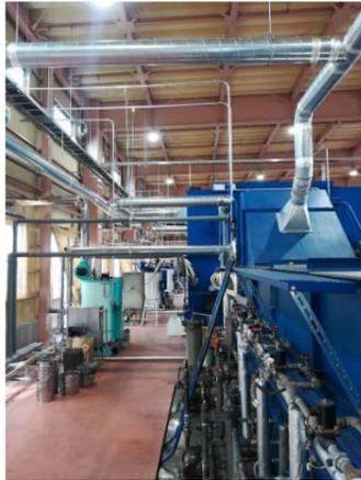
各洗浄装置からダクトを通じてトリクロロエチレン由来の排気を集め、ろ過装置へ送っている。
