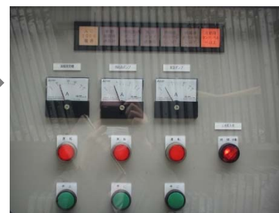
装置内の様子がわかる表示板。廃捺染糊が無くなっていないかについても、ここで確認する。
