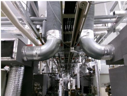
溶剤回収乾燥機で回収できない溶剤ガスは、装置の裏側に設置した排気ダクトで集めて室外へ放出する。
