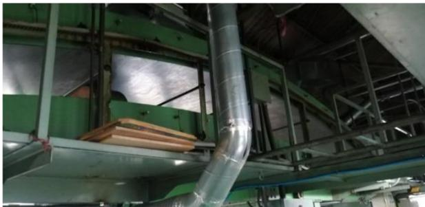
乾燥炉の上の排気口。煙突につながっている。
