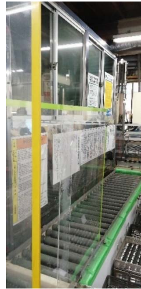
トリクロロエチレンを使用する洗浄設備。密閉構造のため、VOC が極力排出されない。
