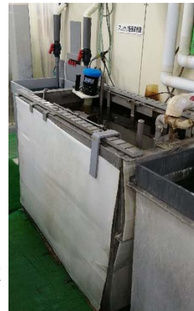
アルカリ超音波浸漬脱脂槽
