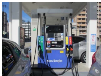
ガソリンベーパー回収装置を搭載したセルフ給油機
