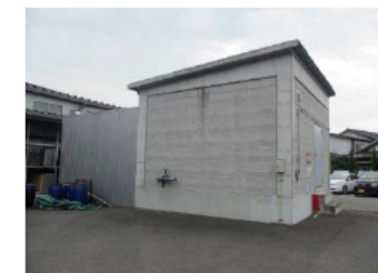
ターペン貯蔵庫。密閉空間で貯蔵している
