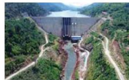
【水力】ナムニアップ1発電所
