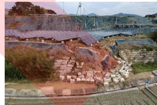
法面保護工が崩れて流出した事例
