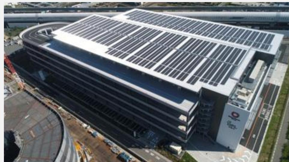
「オンサイトPPA方式」を活用し、太陽光パネル（1.2MW）を設置したマルチテナント型物流施設（埼玉県三郷市）
