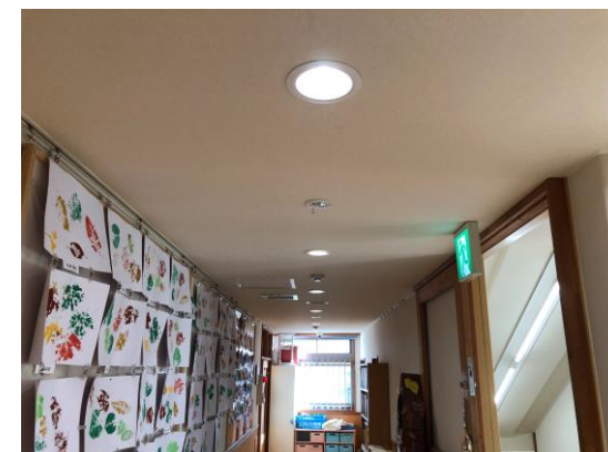
照明器具取替施工後
