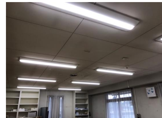
照明設備更新
