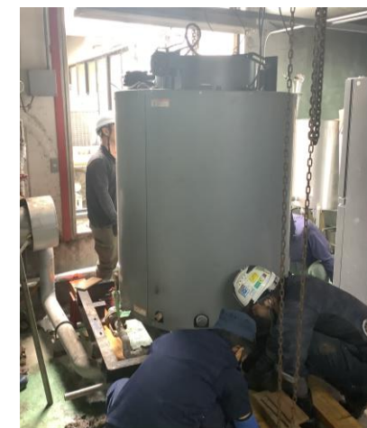
ボイラ設備更新（既存設備搬出）
