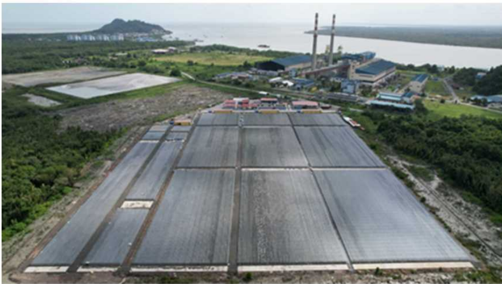
隣接する火力発電所および微細藻類生産設備
