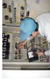
▲ 電気設備技術科 (制御盤製作実習)
