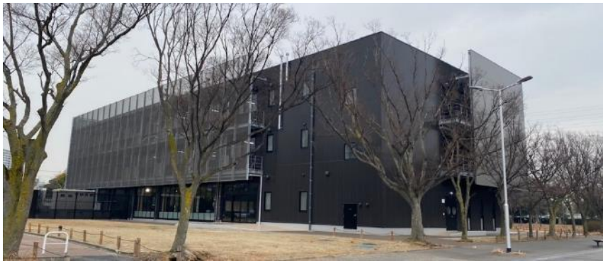
スマートエネルギー棟の外観@なかもずキャンパス
