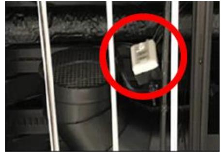
CO<sub>2</sub>センサーで人の活動を探知、自動で適切な換気を行う
