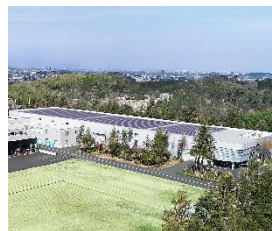
太陽光パネル設置写真
