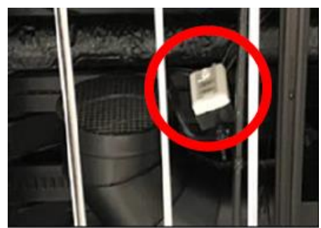
CO 2 センサーで人の活動を感知、自動で適切な換気を行う
